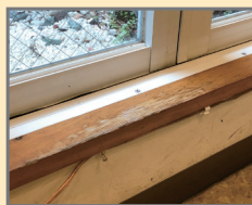
窓枠の劣化
